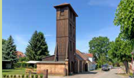
Feuerwehrgerätehaus mit Schlauchturm
